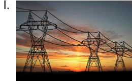
Sarkık elektrik telleri
